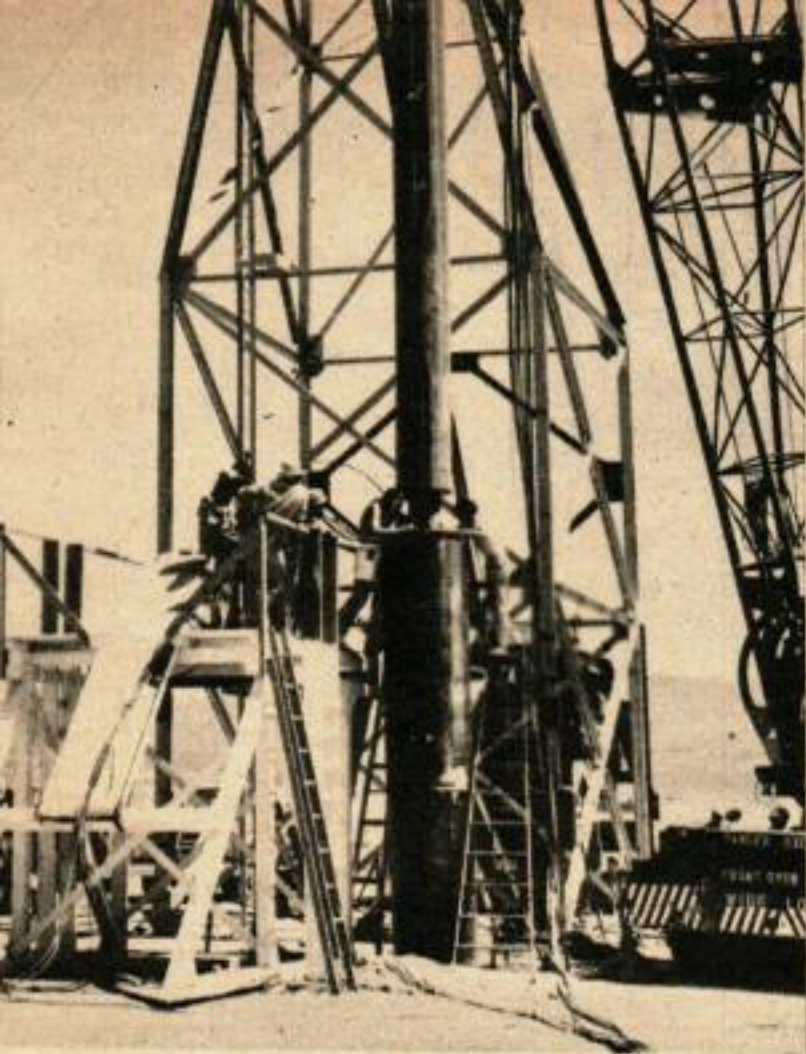
L'EXPLOSIF NUCLEAIRE que l'on descend au cours d'une expérience d'explosion souterraine est du même type que celui de Gasbuggy.
