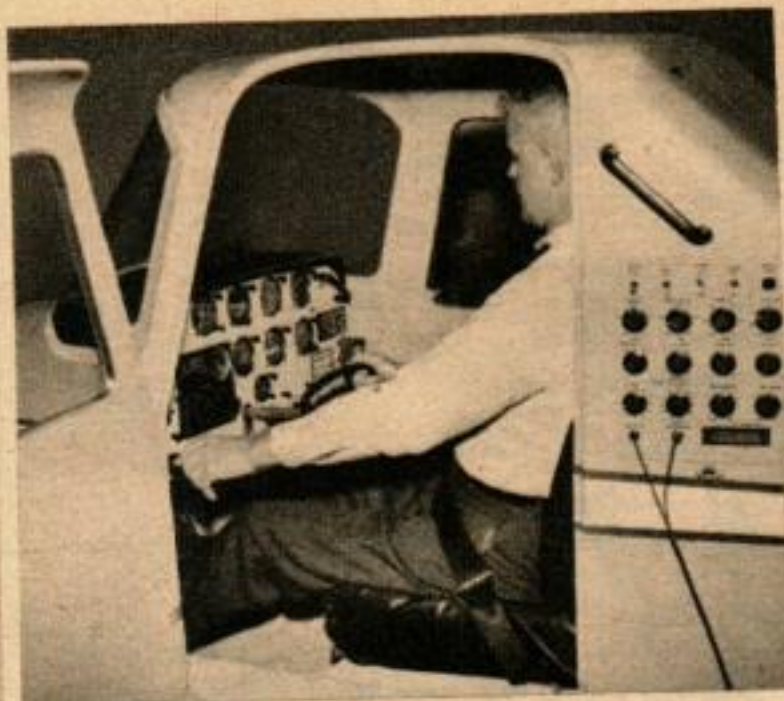
L'AUTEUR EST AUX COMMANDES DU GAT-1 (à droite). Le tableau de bord est une copie fidèle de celui d'un monomoteur. Le bruit de l'hélice et du moteur augmentent le réalisme. Les cadrans à gauche de la porte servent à l'instructeur à régler les caractéristiques normales du vol ou des instruments, ou à introduire des effets anormaux pour voir comment l'élève réagit dans les circonstances spéciales. L'enregistreur vertical (à gauche) trace la ligne de vol sur une véritable carte.
