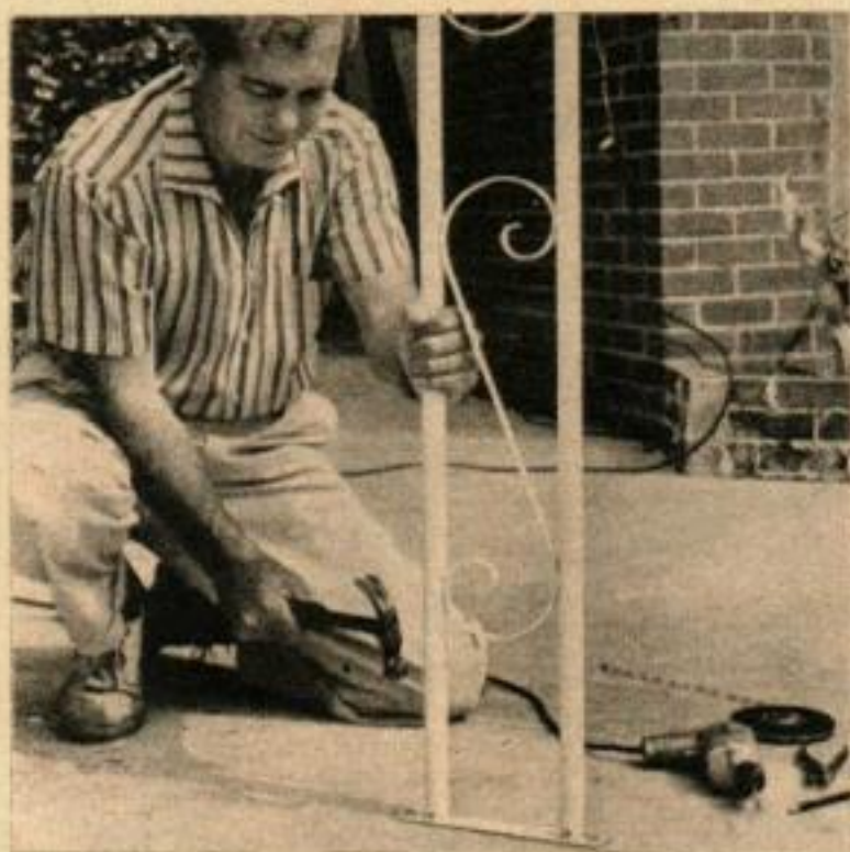
LES POTEaux DECORATIFS ont des pièces de fixation des deux côtés; on les ancre dans le béton en mettant des tampons dans des trous percés d'abord. Pour faire ce trou il faut un burin ou une mèche spéciale.
