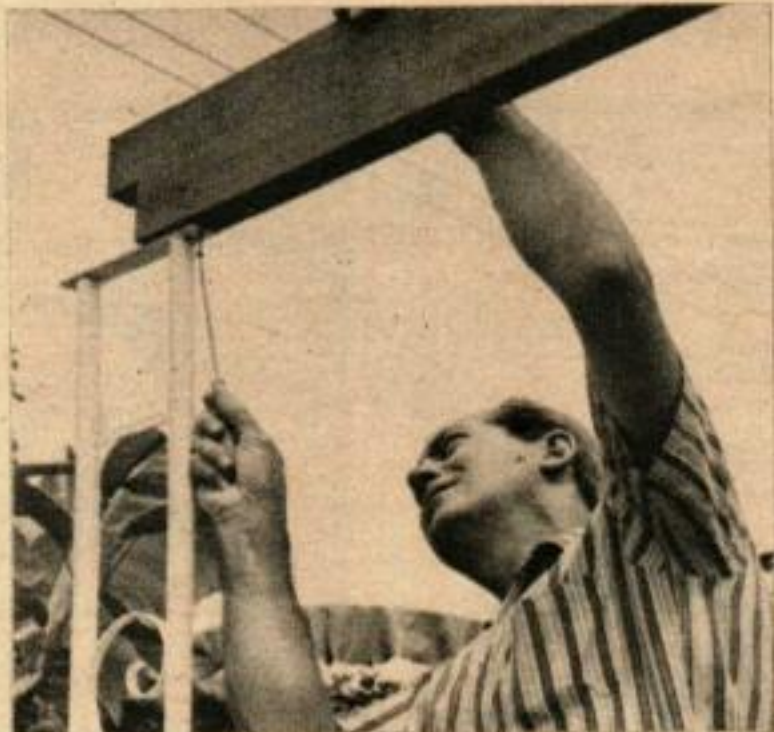
LE TOIT TRANSLUCIDE de gauche utilise des panneaux de fibre de verre Filon, sur une charpente en « caisse d'œufs ». La poutre avant est posée sur des poteaux décoratifs, ci-dessus.
