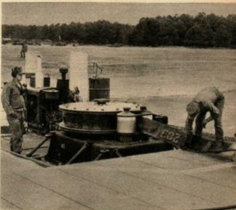
L'EQUIPE DE SOL des Marines passe un produit antiabrasif sur la bande pour qu'elle ne se colle pas ; on la décroche pour l'envol.
