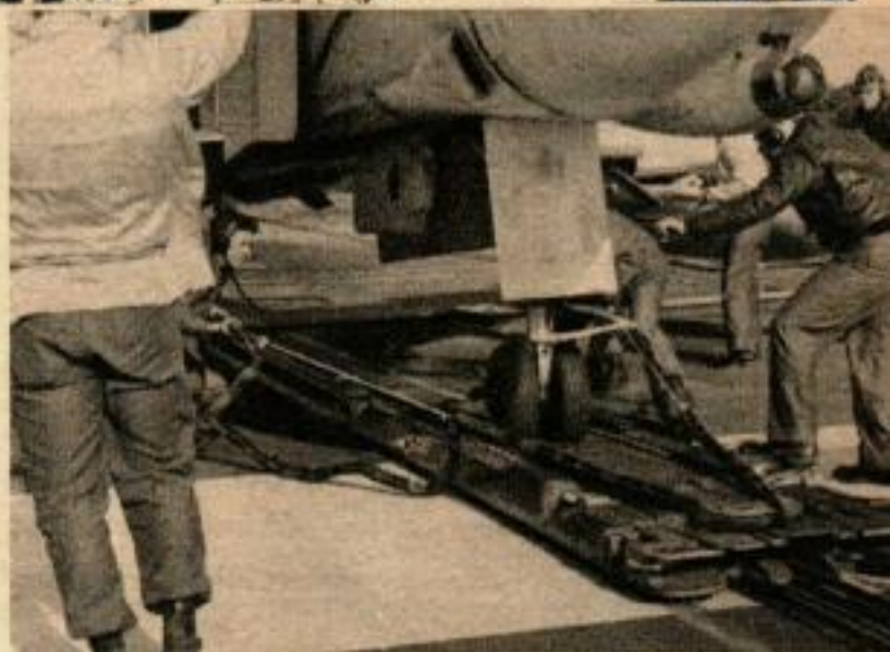
LE CHARIOT DE LA CATAPULTE est accroché au « F4 » avant d'être lancé du terrain des Marines. Les dents que l'on voit devant le chariot prennent le câble d'arrêt au bout du terrain.
