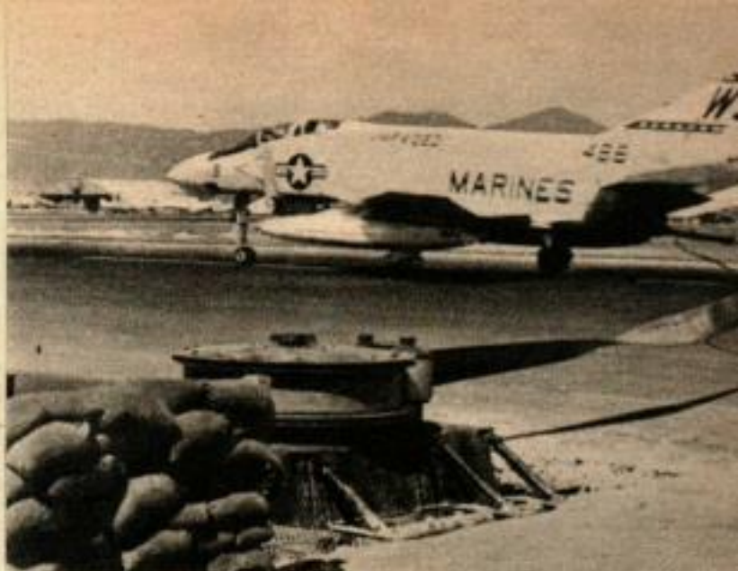
UN AUTRE « F-4 » accroche le câble, et les bandes de nylon, enroulées sur les tambours, commencent à entrer en action pour l'arrêter rapidement.
