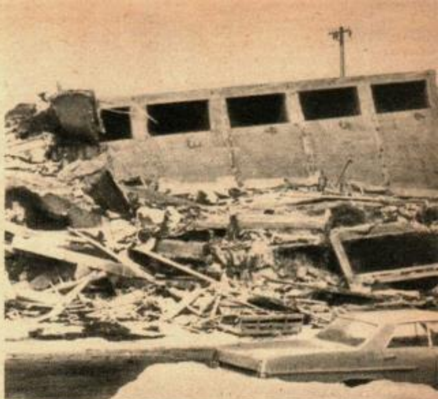
CE TAS DE DEBRIS est tout ce qui reste d'un immeuble de six étages à Anchorage, en Alaska, après la secousse de 1964. Les liaisons entre le plancher et les montants ont cédé et tout s'est écroulé. Ci-dessous, à l'université Lehigh, des expériences sont faites sur une charpente grandeur nature.
