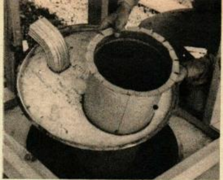
ON DECOUPE DES OUVERTURES dans le dessus du tonneau pour y passer le coude de la descente et un tuyau de 305 galvanisé venant de la boîte.
