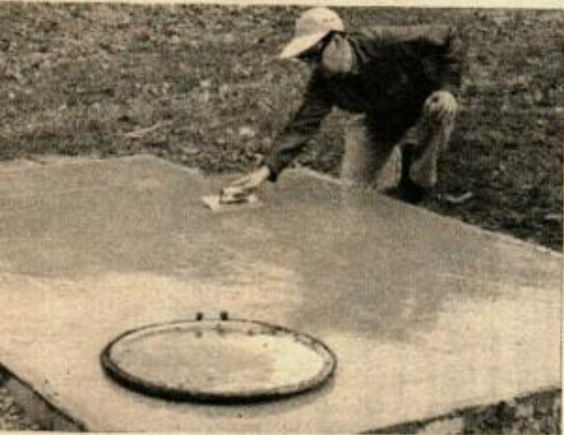
LA DALLE EST TERMINEE ; on voit le tonneau placé un peu en retrait du coin. La petite dalle en contrebas est une marche devant la porte.
