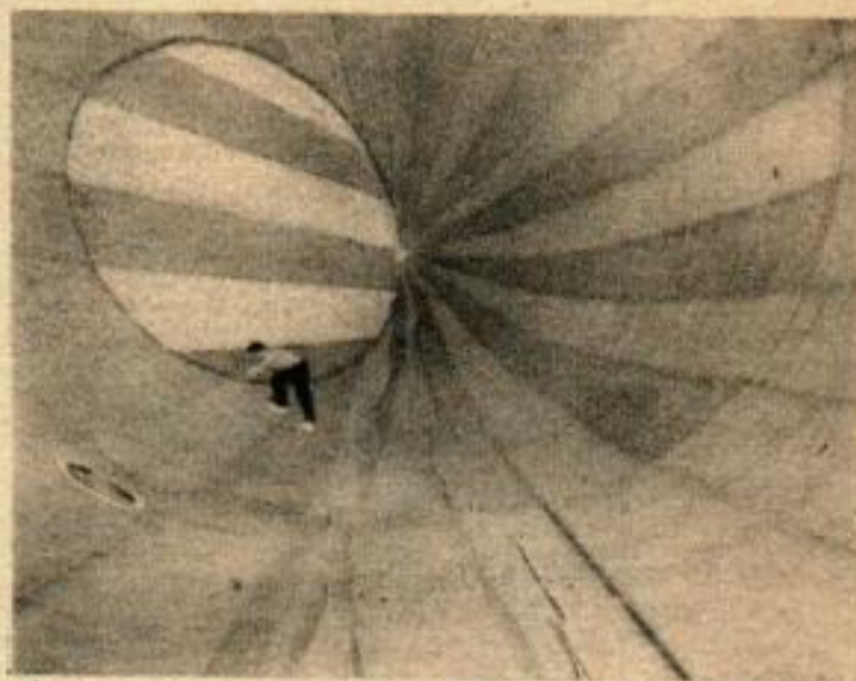
LE BALLON GEANT DE 5 000 M 3 en forme de V construit par la Division Aéronautique de Goodyear est en train de transporter deux énormes troncs d'arbres. Associé à un treuil ultrarapide, la nouvelle grue aérienne est capable de véhiculer 10 tonnes de grumes à la fois sur un parcours d'environ 800 m.
