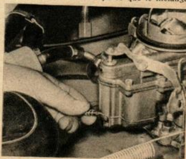
SI LA VIS DE MELANGE EST ABIMEE, on est sûr d'avoir des ennuis. C'est une mauvaise panne et souvent on n'y pense pas en faisant la mise au point du carburateur.
