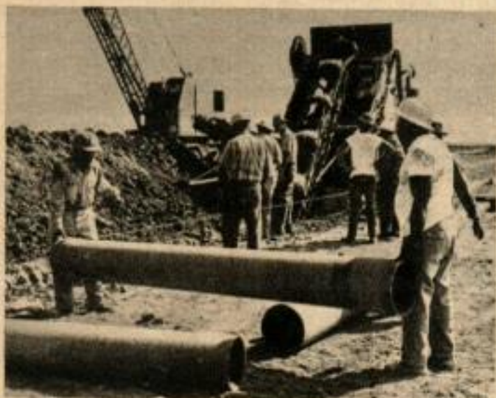
ON MET DES TUYAUX dans la terre pour enlever l'eau d'un terrain trop salé.
