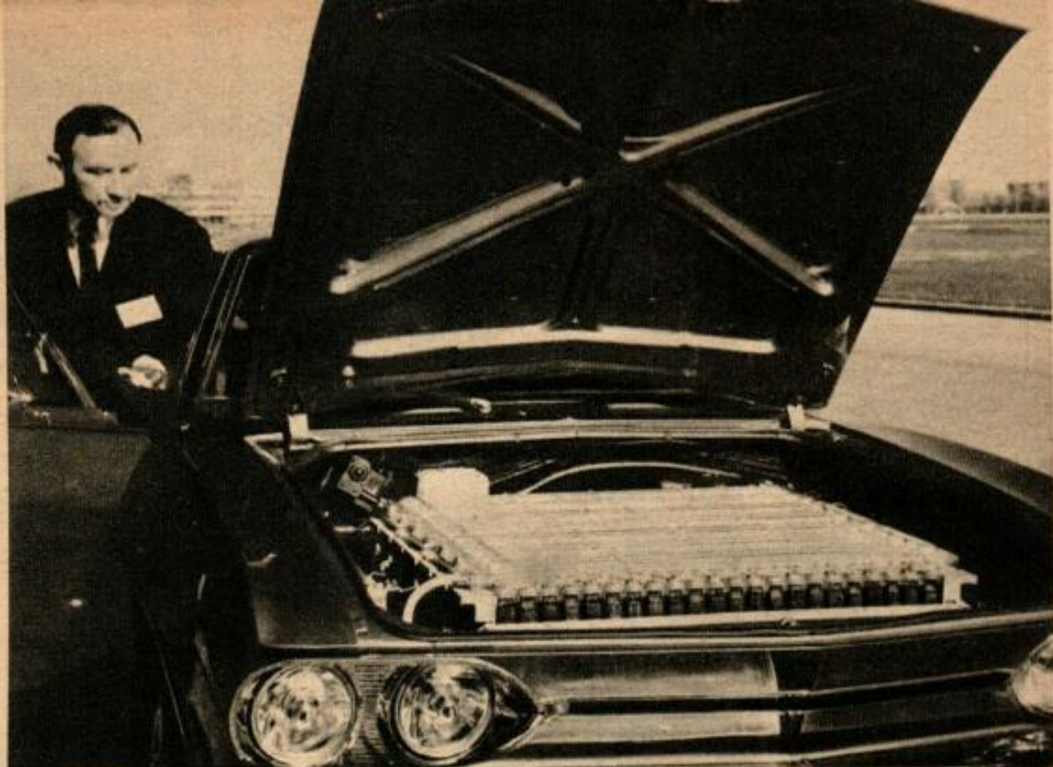
LE CHEVAL DE BATAILLE de la General Motors est l'« Electrovaïr II », photographiée au cours d'une récente manifestation. L'énorme batterie zinc-argent donne de la vitesse, mais peu d'autonomie.
