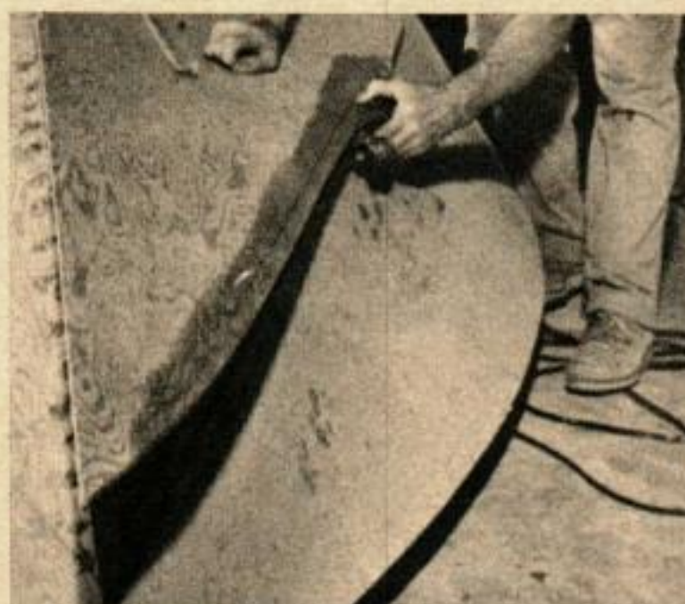
POUR ASSEMBLER A PLAT le bordage avant, humidifier le contreplaqué pour qu'il ne s'écaille pas.
