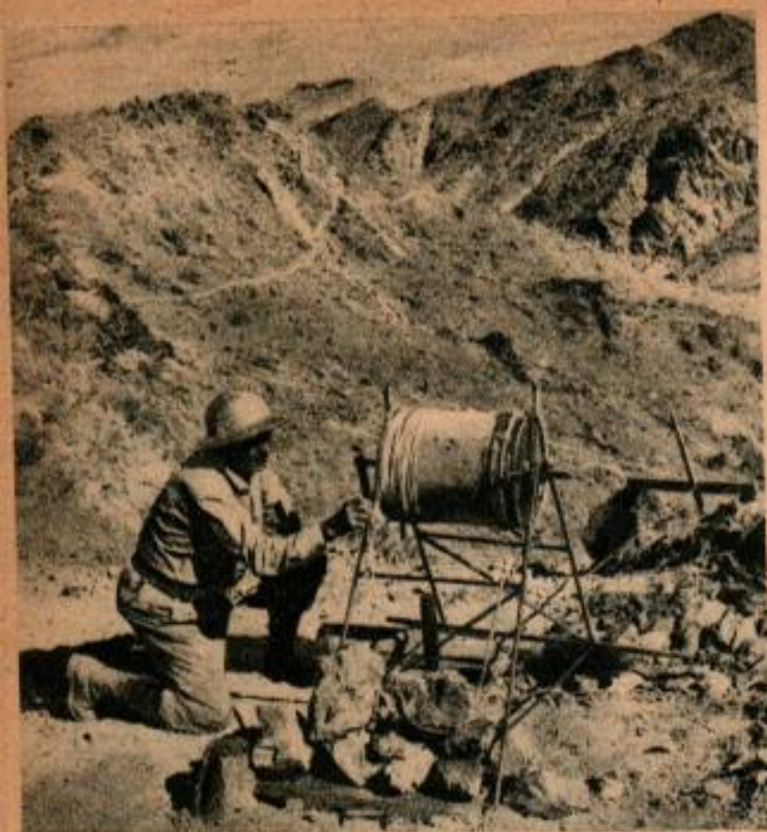
Monté jusqu'au sommet en pièces détachées, ce treuil permet de hisser le matériel lourd le long des pentes abruptes de la montagne.
