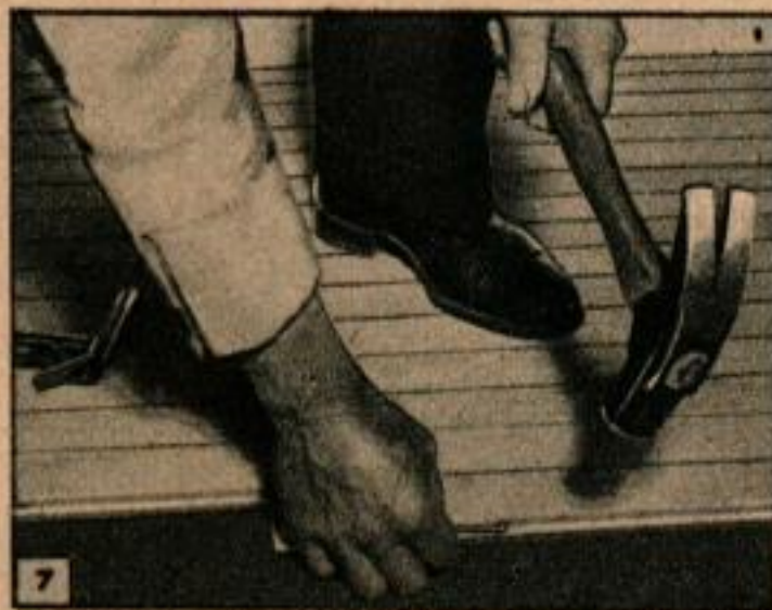
Les têtes des clous doivent venir à ras ou légèrement en dessous de la surface. Un clou taillé ou un chasse-clous ordinaire fera l'affaire.
