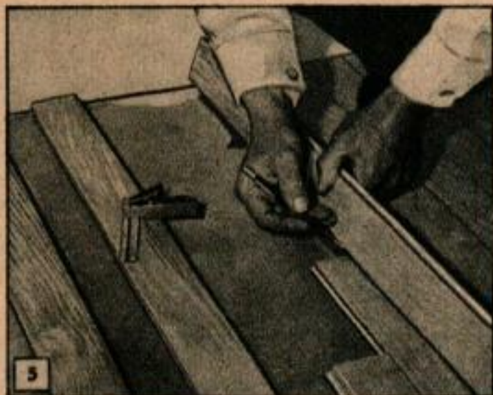
Les têtes des clous doivent venir à ras ou légèrement en dessous de la surface. Un clou taillé ou un chasse-clous ordinaire fera l'affaire.
