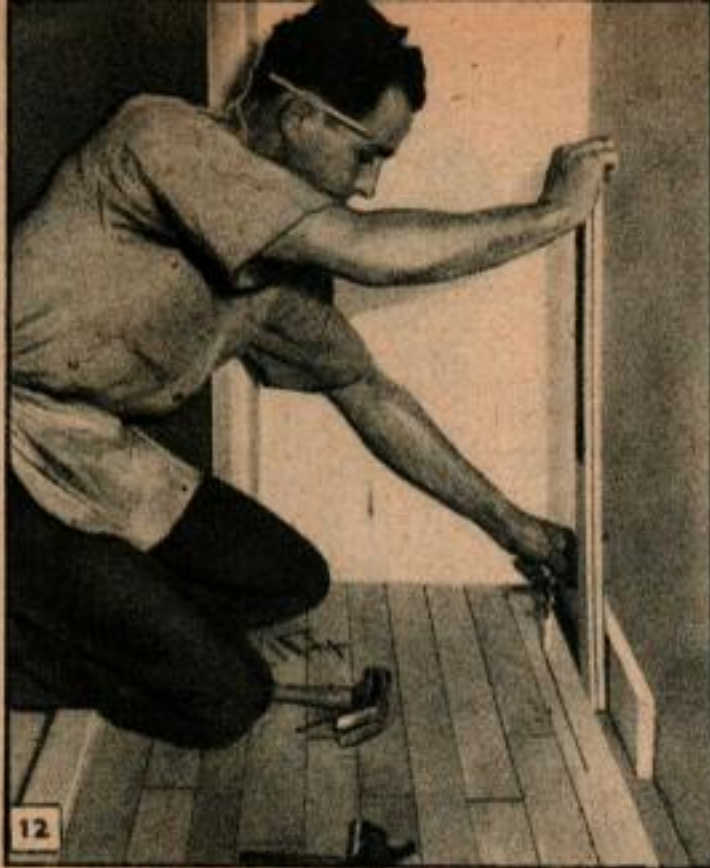
12 Une lame de remplissage courbée est forcée en place pour marquage en faisant levier contre le mur avec une planche et un bloc de bois.
