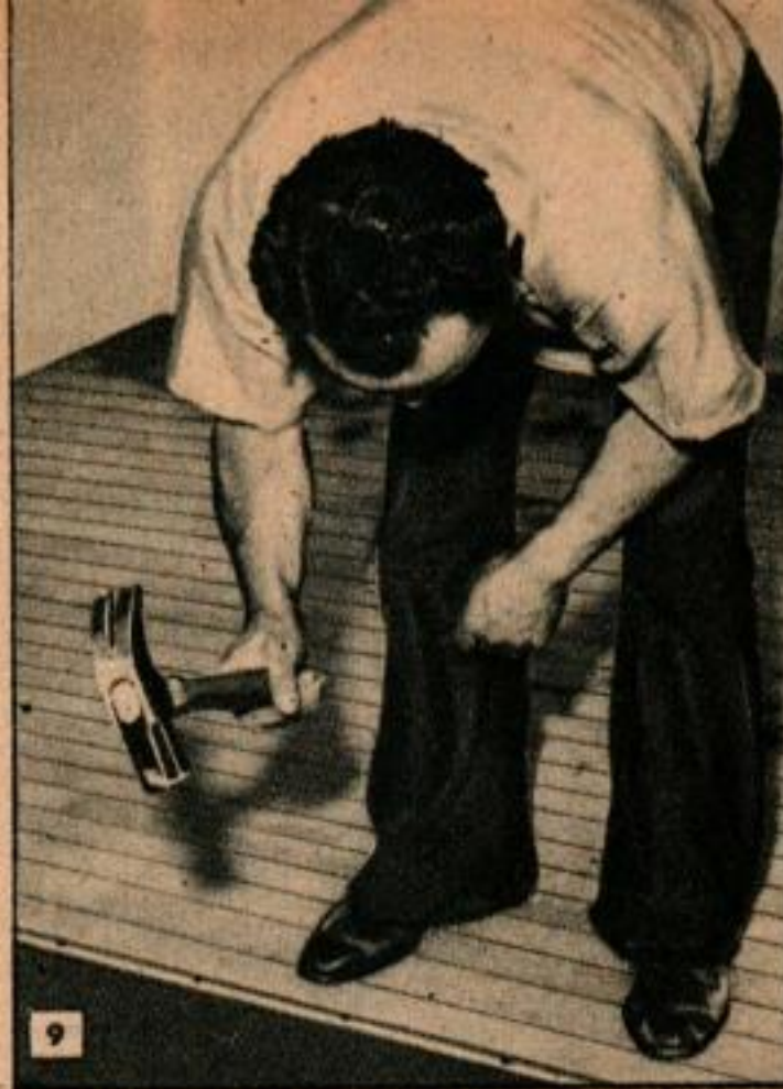
La pratique vous permettra d'enfoncer rapidement les clous dans la position debout. Les têtes sont enfoncés ensuite au chasse-clous.
