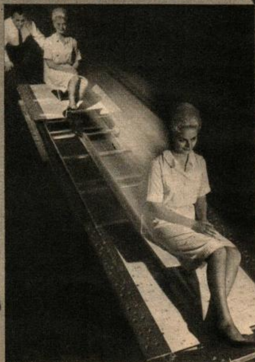
LE TRAIN SANS FROTTEMENT DE L'AVENIR ? Des aimants montés sous le véhicule et sur les rails se repoussent, maintenant ainsi le véhicule soulevé en l'air. On peut alors le pousser avec le doigt.
