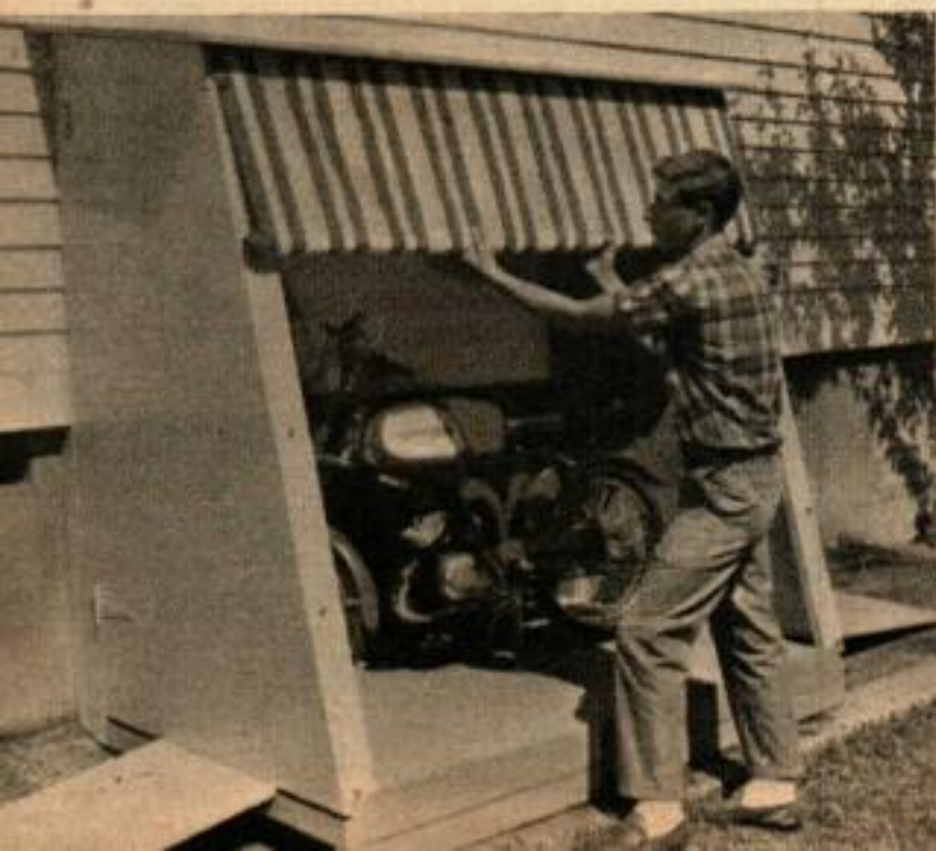
AUVENT A RIDEAU DE TOILE appuyé contre le garage ou la maison, s'ouvre complètement pour donner un accès facile. Le rideau se boutonne sur les côtés.
