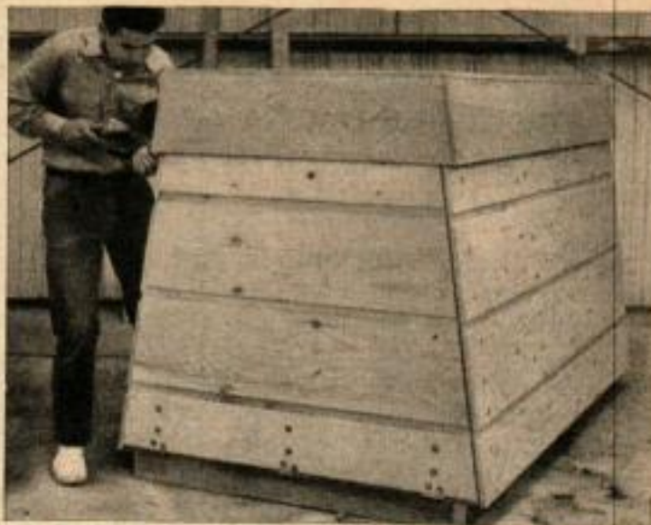
LE TOIT COIFFE LES PAROIS en pyramide de la baraque comme le couvercle d'une boîte et sert à maintenir la rampe relevée sans crochet.
