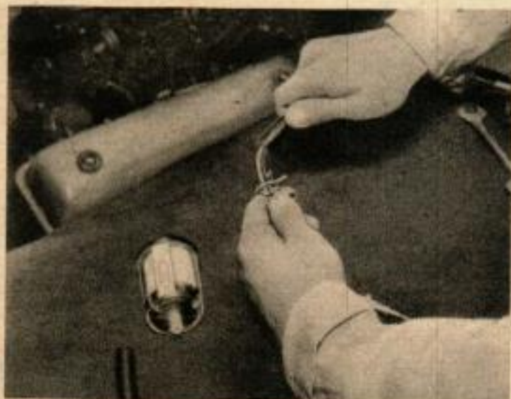
PLACER LES TUYAUX ET LES COLLIERS DE SERRAGE aux extrémités coupées de la canalisation en vérifiant la direction d'écoulement.
