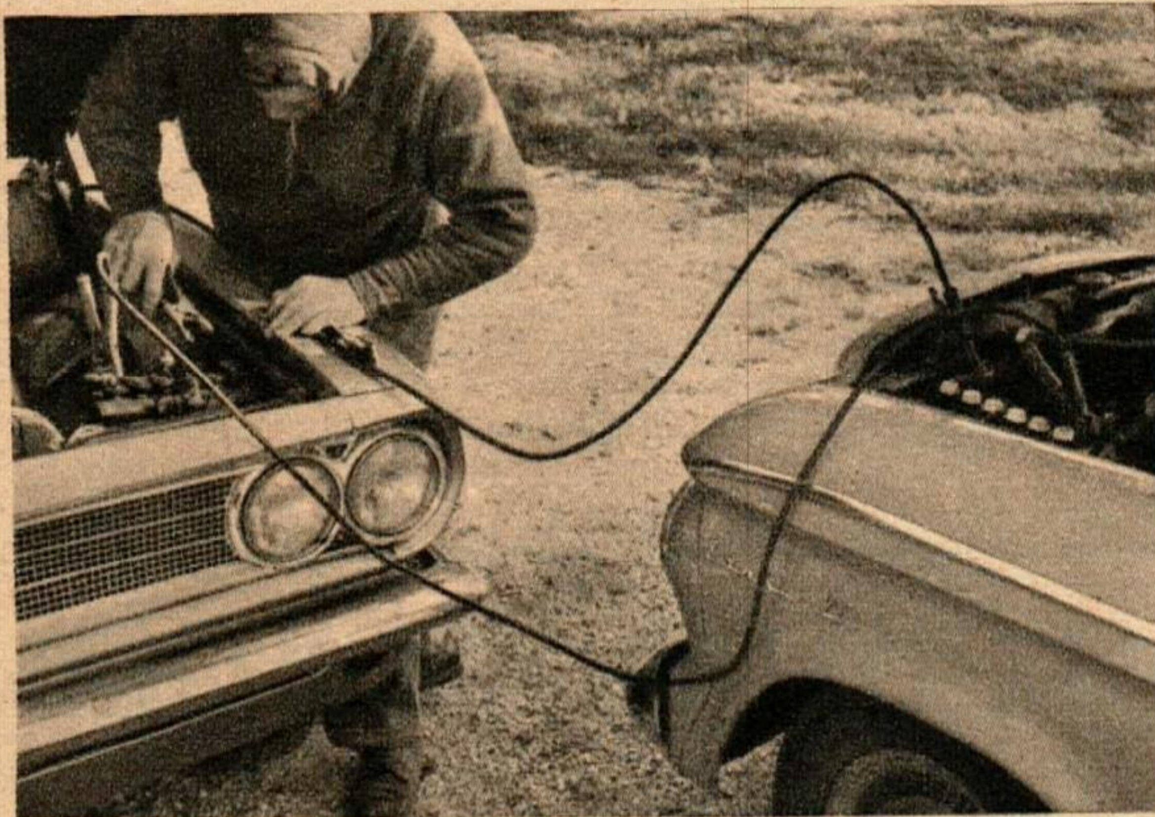
LES CABLES DE BRANCHEMENT permettent de faire partir le moteur avec la batterie d'une autre voiture, mais il ne faut pas inverser la polarité, sinon les redresseurs de l'alternateur seront grillés.
