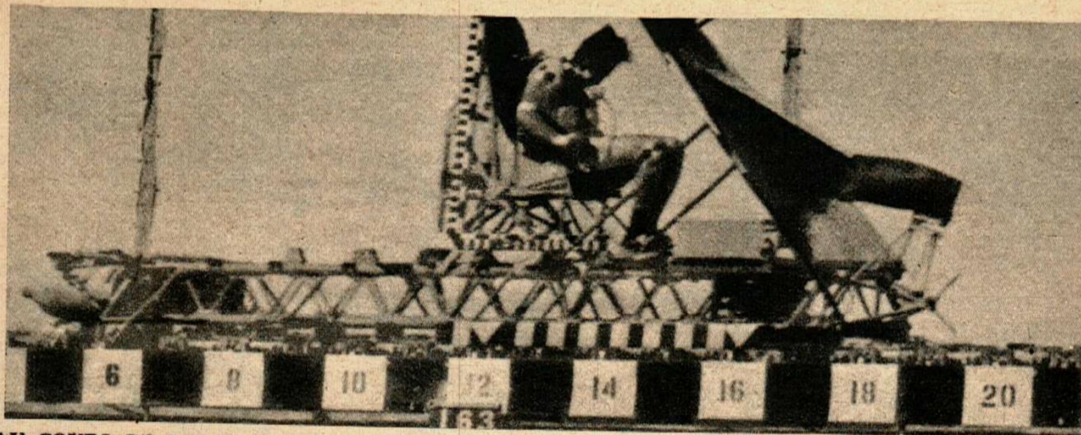
AU COURS DE LA CÉLÈBRE EXPERIENCE avec un harnais de sécurité, le colonel John Stapp a survécu à une terrible accélération de 38,1 g, lorsque son traîneau à réaction s'est arrêté presque instantanément après avoir atteint la vitesse de 280 km/h.
