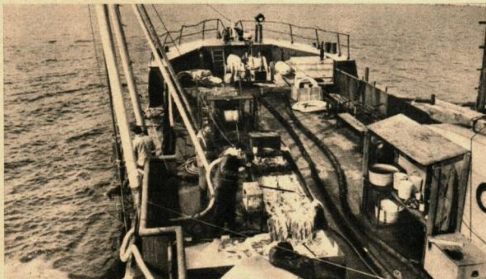
LE GRAVIER ET L'EAU DE MER qui sont pompés du fond passent sur la rampe de lavage installée sur le navire de prospection.
