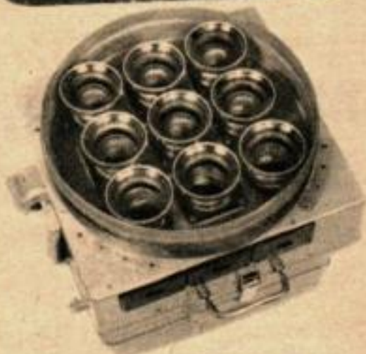
UNE CAMERA A NEUF OBJECTIFS photographie la cible en même temps avec neuf filtres différents... Les deux vues ci-dessus du même site révèlent des différences remarquables. Le cours d'eau qui est à peine visible sur la photo du haut se détache nettement sur la photo du bas prise avec un autre filtre.
