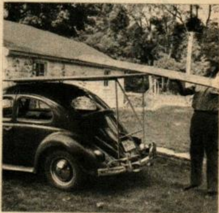
LES VOLKSWAGEN BATTENT LA PLUPART des camionnettes avec ce râtelier sur lequel on peut poser des planches à plat. Avec le drapeau rouge réglementaire à l'arrière vous pouvez même transporter des pièces de 4,20 m bien calées.
