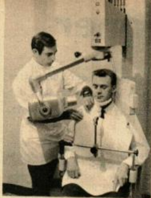
LA NOUVELLE MACHINE PANORAMIQUE (à gauche) prend une radiographie de toute la bouche en une seule fois, par mouvement du tube de Roentgen autour de la figure du patient. L'objectif est réglé de manière à faire apparaître les dents antérieures du patient de part et d'autre de la colonne vertébrale.
