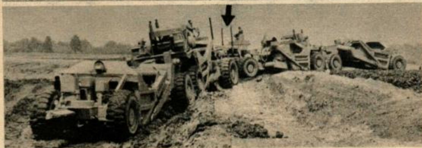
LES CINQ UNITES DE CET EXCAVATEUR ELECTRIQUE, dirigées par un seul homme prennent 150 t de terre en quelques minutes.
