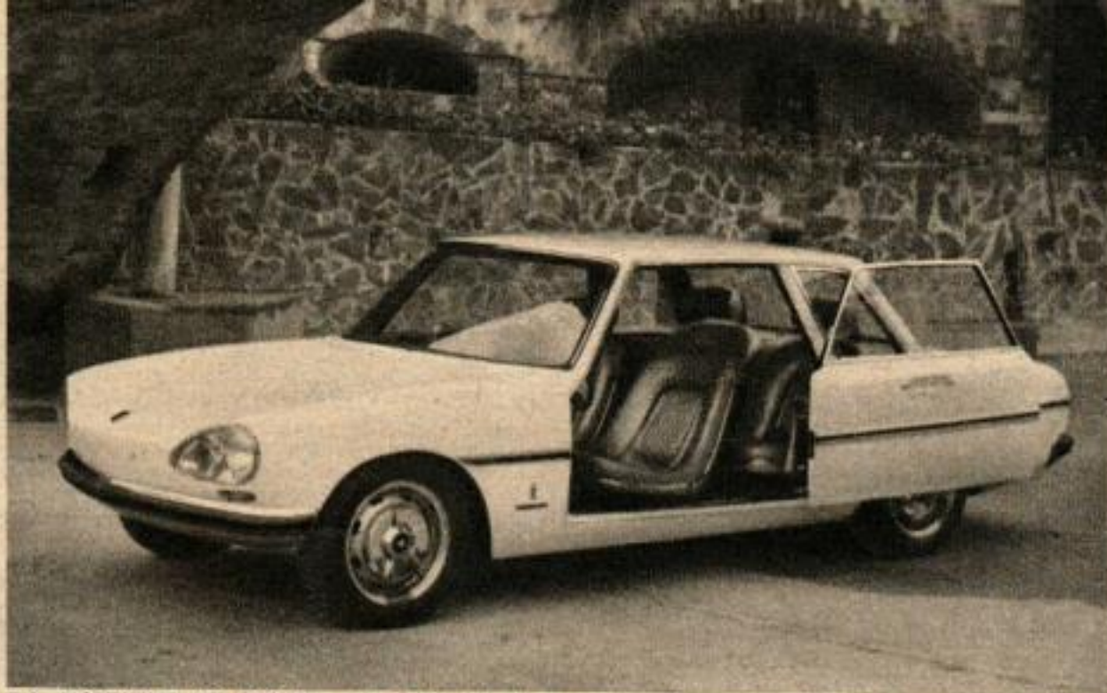
LA VOITURE PF SIGMA est dotée de deux portes glissantes qui sont rapprochées de la coque et qui coulissent vers l'arrière. Les portes ne peuvent s'ouvrir de façon à empêcher le passage d'une autre voiture. D'ailleurs, elles restent fermées en cas de collision latérale.
