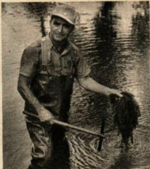
UN OUTIL SPECIAL , un couteau de boucher, attaché au bout d'un long manche en bois, ramasse la mousse entre les lames, puis retourne les plantes pour les couper.
