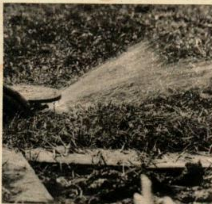
DES DIFFUSEURS ESCAMOTABLES sont installés dans des trous de 40 cm de profondeur et sont maintenus par un ballast de pierres. Quand l'arrosage est arrêté, le diffuseur s'escamote dans le trou à ras du sol.
