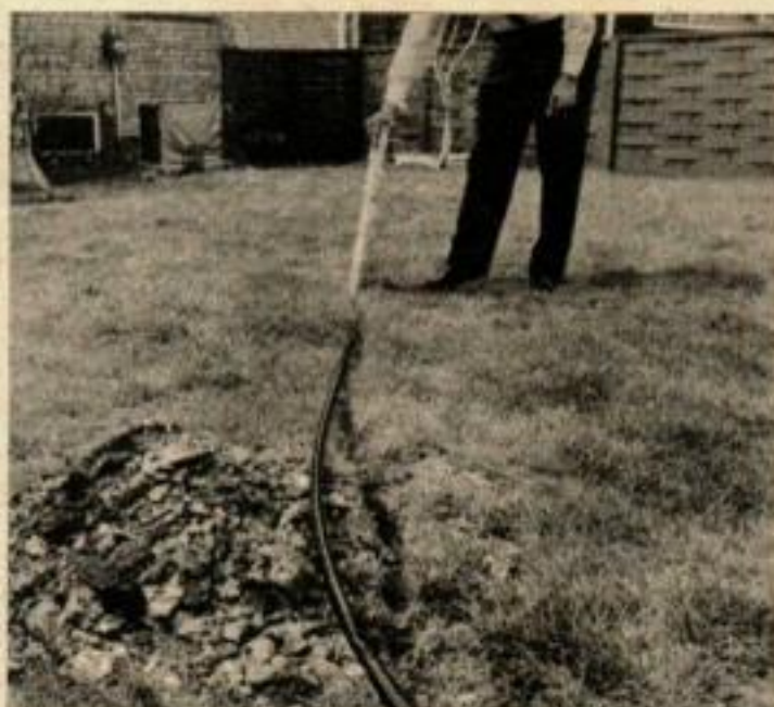
LA TRANCHEE OUVERTE POUR LE TUYAU conduit au poteau où sera installée l'arroseuse Sears Sprinkler Matic. Un seul diffuseur permet d'arroser une surface de 24 mètres de diamètre.
