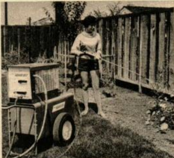
DES PRODUITS CHIMIQUES sont appliqués avec l'Aquablast pour le traitement des plantes. Le réservoir contient 115 litres et un moteur électrique fait marcher la pompe de compression.
