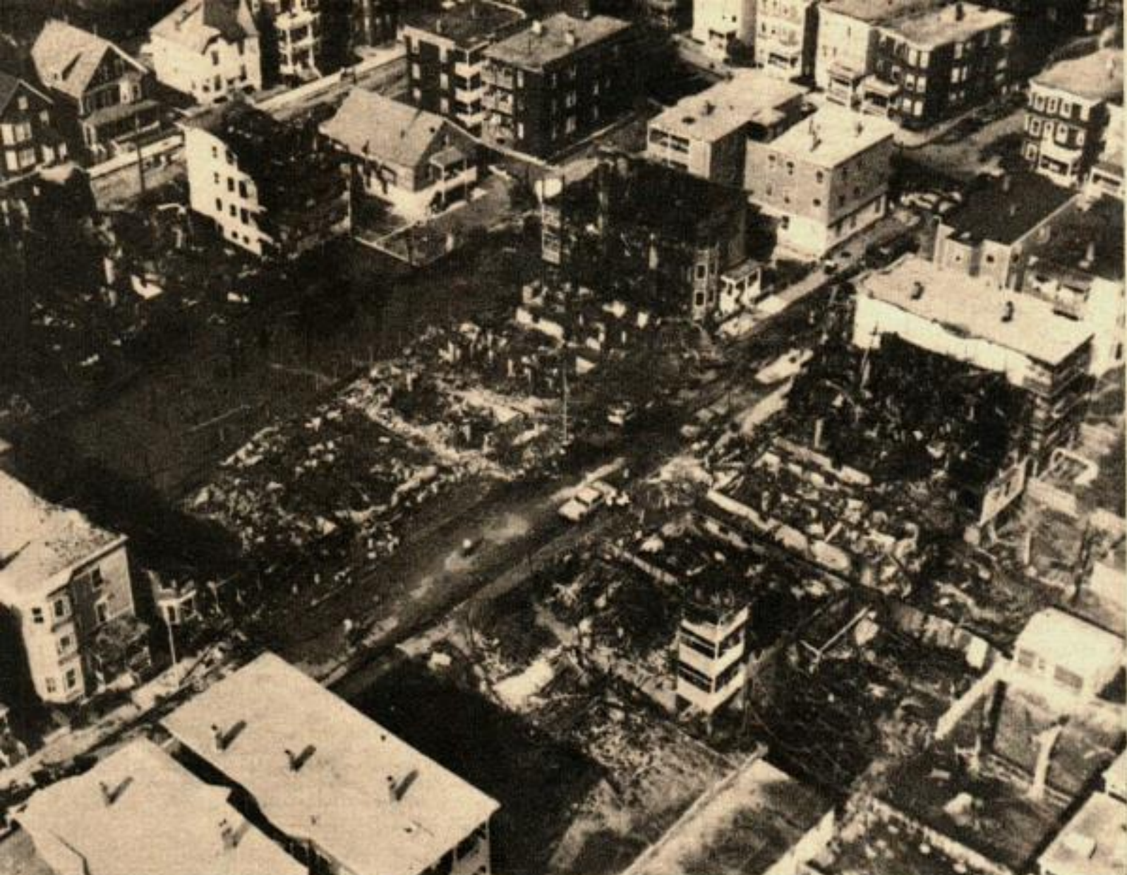
BELLFLOWER STREET, dans le district à Dorchester, à Boston, à la suite d'un incendie, il y a deux ans. Cet incendie a servi de modèle pour des recherches sur la propagation du feu.
