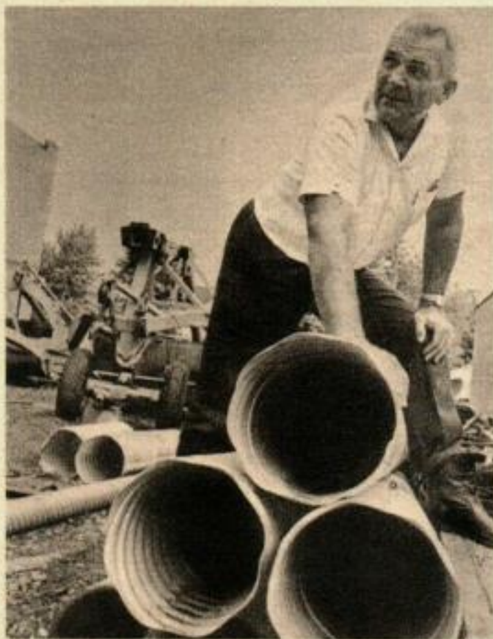
LES TUYAUX D'ALUMINIUM que chevauche Kerkel Karch sont placés à la base des digues pour faire écouler l'eau qui, autrement, resterait trop longtemps.
