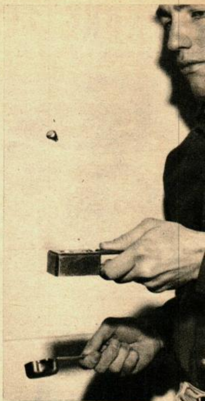
DES PLOMBES EN 7 CALIBRES sont facilement moulés et éjectés dans le moule Silverbell Vari-Mold qu'on tient à la main.
