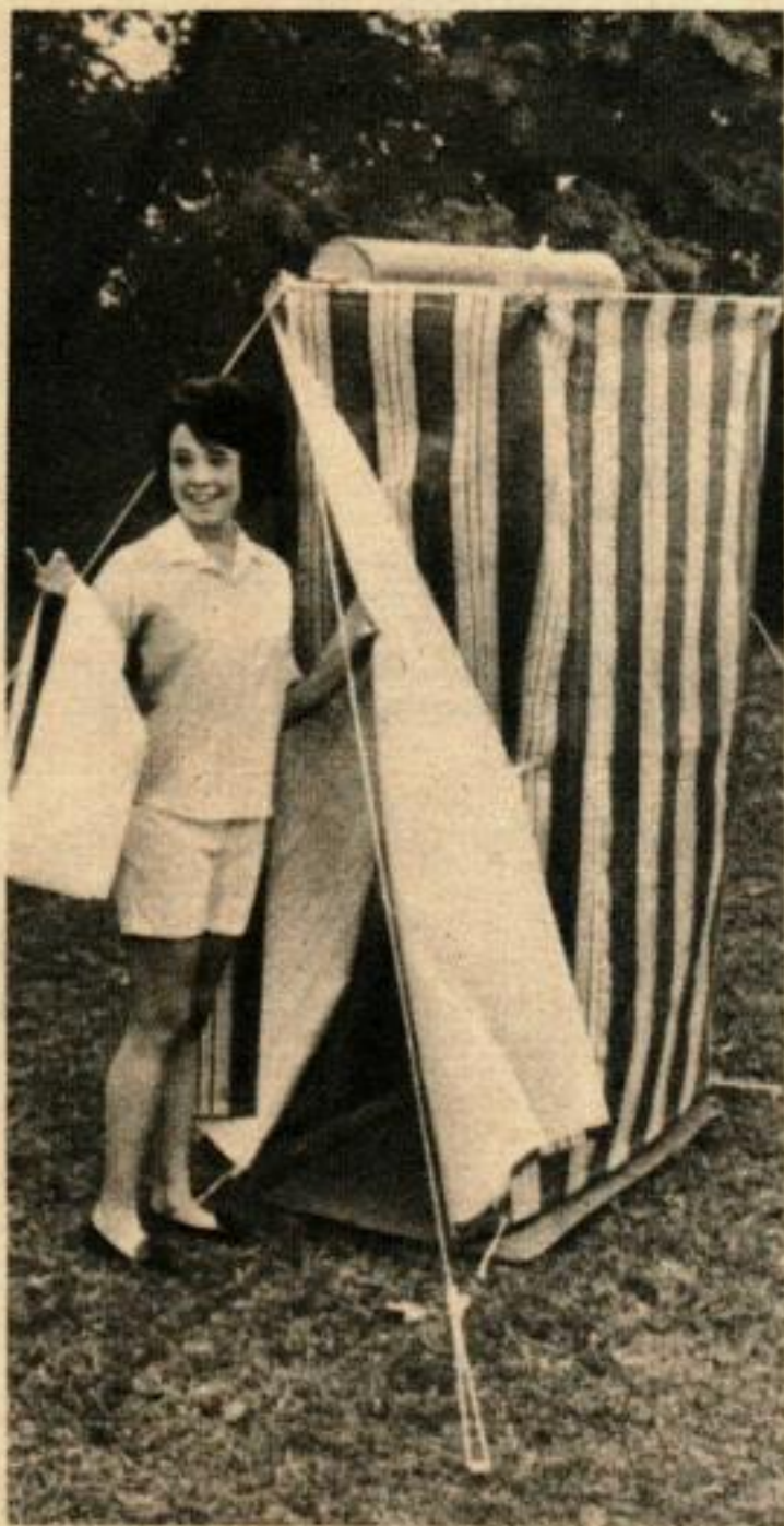
CETTE DOUCHE DEMONTABLE a un réservoir de 18 litres d'eau monté sur pivot et pouvant fonctionner pendant 12 minutes.
