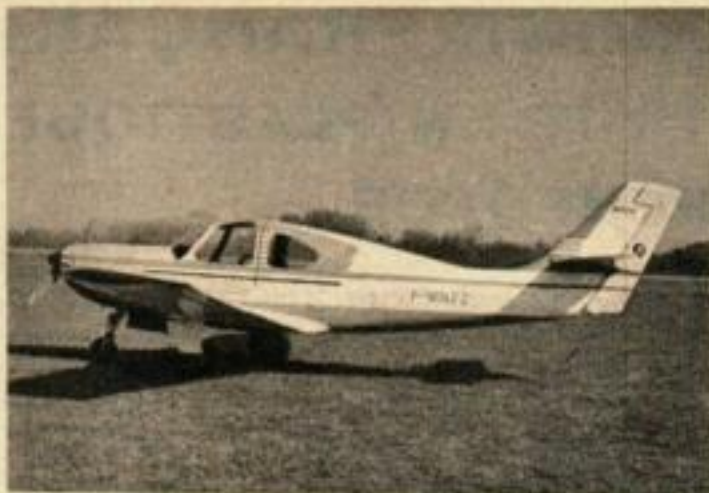
Voici le « Wassmer 50 » premier avion au monde construit entièrement en plastique. Mû par un moteur de 150 CV, il possède un train d'atterrissage escamotable et atteint facilement une vitesse de croisière de 260 km/h. Ateliers de Wassmer Aviation, à Issoire (Puy-de-Dôme).
