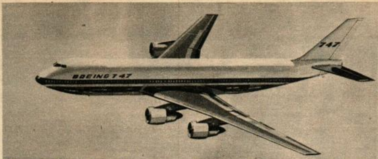
LE BOEING « 747 » EN VOL AU-DESSUS DE L'ATLANTIQUE NORD. Les hublots sont grands. Et pourtant, ils ont l'air petits. Ce qui en dit long sur les proportions de ce mastodonte. Longueur hors tout : 69,64 m, y compris la voilure arrière en porte-à-faux.
