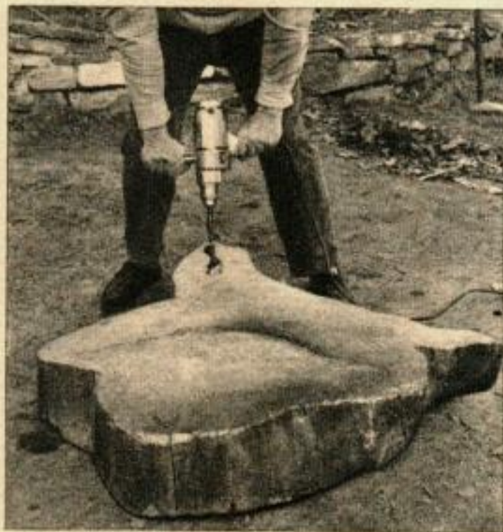
UNE MECHE GEANTE perce des trous de 45 mm à 75-100 de profondeur dans la table ; on y mettra les pieds.
