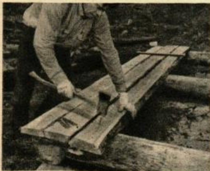
9. CLOUEZ AUX FONDATIONS. Alterniez la position des joints en biais, comme le montre la photo de gauche. Quand toutes les planches sont posées, on égalise le bout à la scie.
