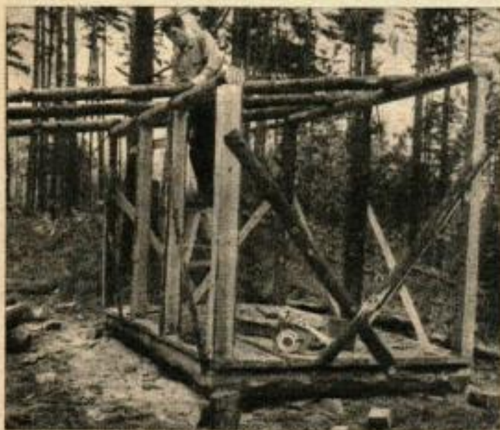
14. L'ALLURE GENERALE DE LA CABANE est visible, avec l'avancée du toit du côté de la porte. Les étais restent jusqu'à la pose des décharges.
