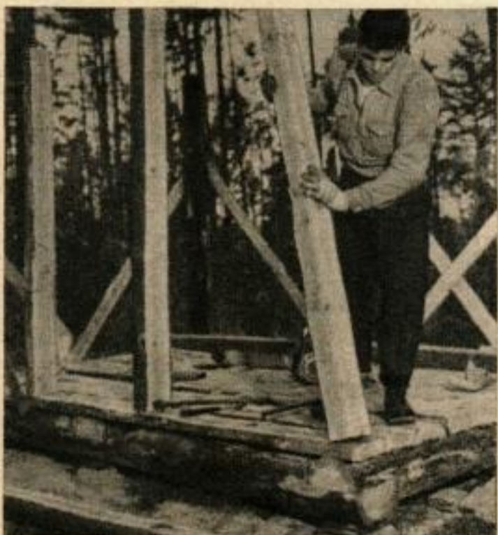
10. POTEAUX DE COIN. On a pris des grumes de 200 et on les a refendues sur deux côtés à angle droit, en conservant les morceaux.
