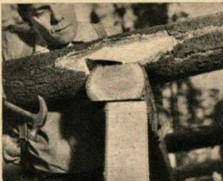
13. QUATRE CHEVRONS de 4,26 mètres sur 125 de diamètre reposent sur les corniches, le gros bout vers le faite, avec des entailles de 25 mm qui s'adaptent aux corniches.
