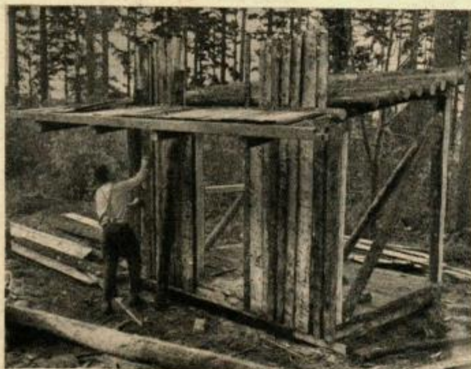
21. LES PAROIS, dont les planches sont fournies en partie par les dosses, sont fixées avec des pointes 115 dans la charpente. On les pose comme elles viennent, puis on égalise à la scie.
