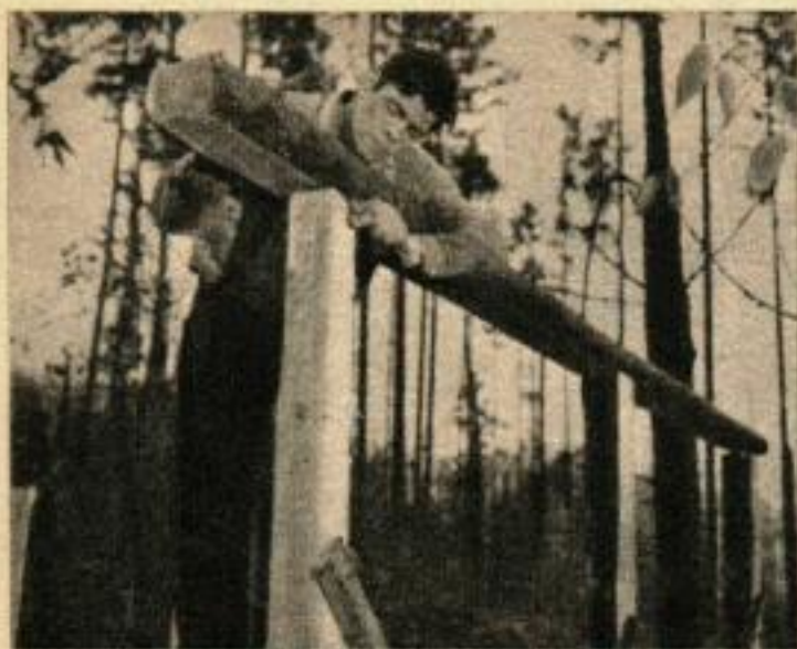
12. LES CORNICHES sont des troncs de 150, longs de 3,56 mètres, sur lesquels on a pratiqué un plat pour le clouage : deux pointes de 150 à chaque poteau.
