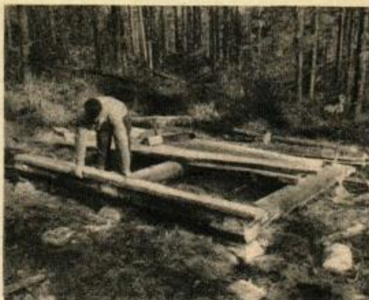
8. LES PLANCHES DE 50 sont posées pour les fondations ; les dosses demi-rondes d'extrémité sont conservées pour un usage ultérieur.
