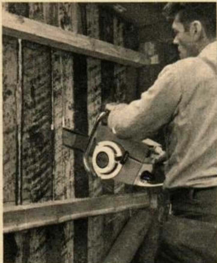
23. ON DECOUPE L'OUVERTURE DE LA FENETRE une fois la cloison posée. Celle que nous avons utilisée dans notre maison pilote est un simple châssis de 710 x 760, mais on peut faire autrement en prévoyant la place.
