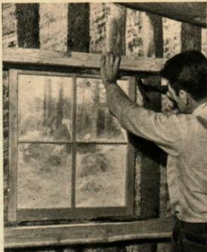
24. ON FIXE LE CHASSIS A LA FENETRE avec des pointes enfoncées dans les entretoises horizontales; puis on calfate. Remarquez qu'on a déjà posé les couvre-joints.
