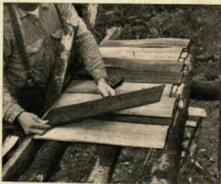
20. LA COUVERTURE CONSISTE en bardeaux posés sur les pannes. Nous avons découpé des billes de cèdre en bûches de 635 mm et nous les avons débitées en bardeaux au mallet et au ciseau.
