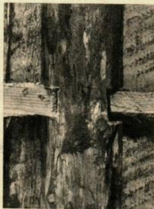
21. LES PAROIS, dont les planches sont fournies en partie par les dosses, sont fixées avec des pointes 115 dans la charpente. On les pose comme elles viennent, puis on égalise à la scie.
