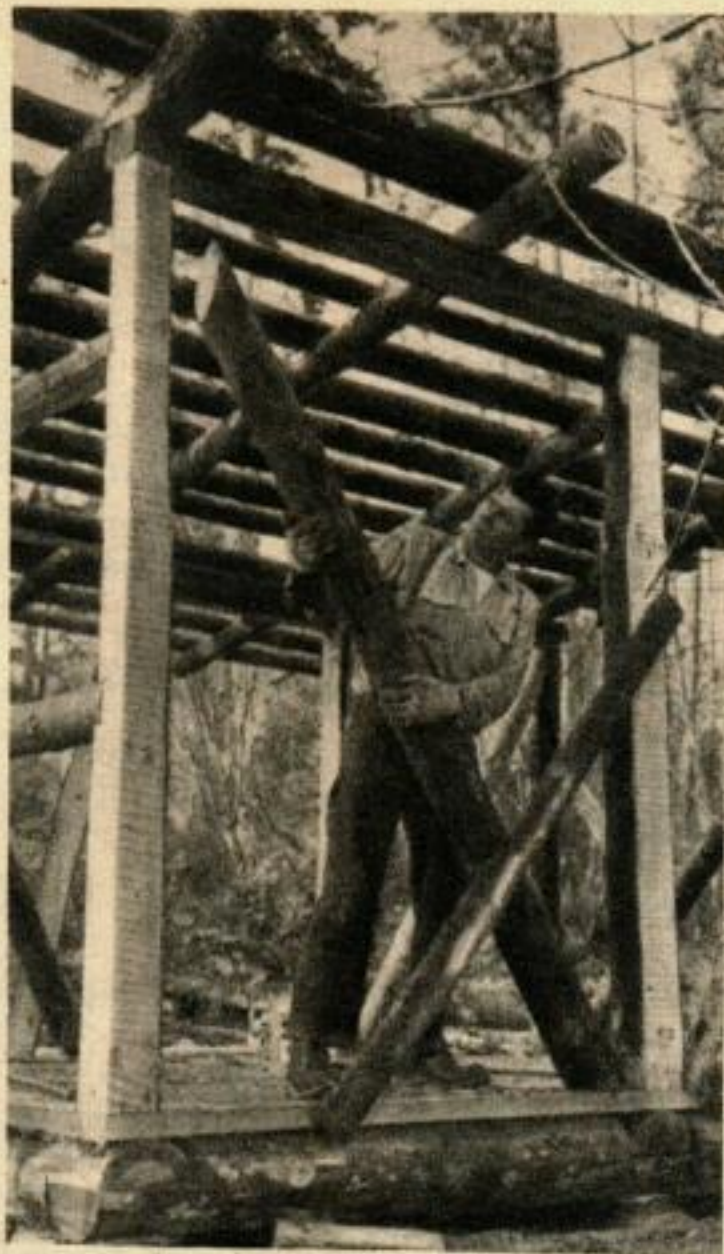
18. LES DECHARGES se placent entre les poteaux, comme on le voit ici pour le mur arrière. Les extrémités sont taillées en biais suivant le poteau et le plancher.
