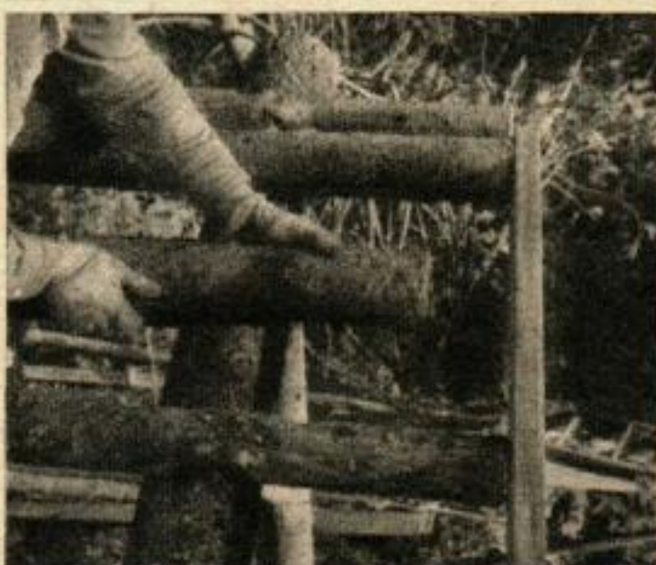
15. SUR LES CHEVRONS, on pose 15 pannes de 4,26 m de long et environ 75 mm de diamètre. On les cloue en haut, en bas et tous les 280 mm. La planche clouée au bout sert à l'alignement.
