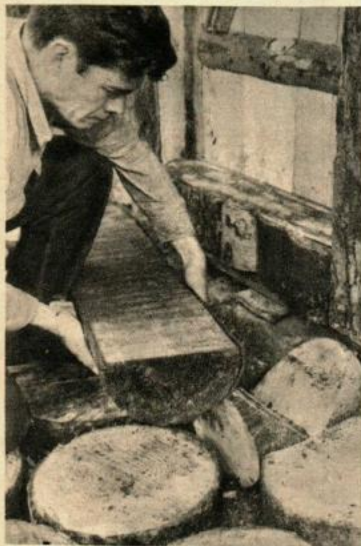
25. LE SEUIL EST UNE BUCHE de 300, longue de 1,20 m, sciée au milieu et posée dans les fentes en V. Les 35 pavés du patio sont des ronds de 100 mm d'épaisseur sciés dans de grosses billes.
