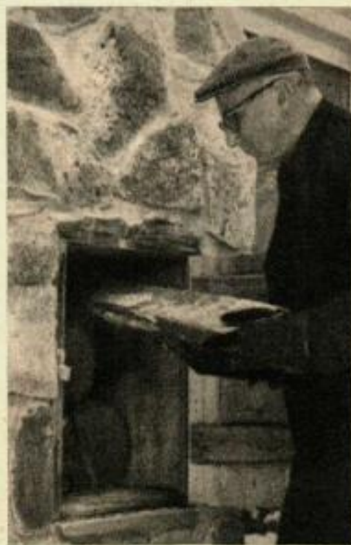
Une idée ingénieuse : une ouverture permet de rentrer le bois sans traverser la maison.
