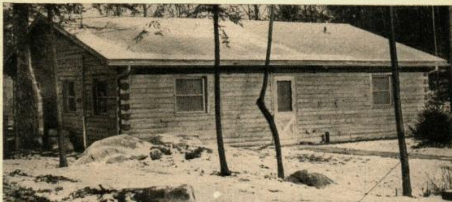
La maison mesure 8,50 \times 11 mètres, avec 4,60 de hauteur maximale sous plafond. Tout est coupé d'avance.
