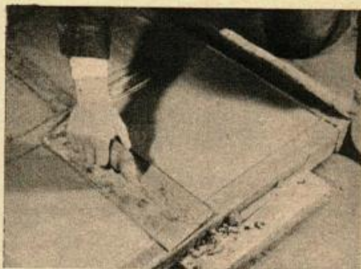
puis répandez le mélange suivant : 4 kg de colorant, 50 kg de ciment, 100 kg de sable, 20 l d'eau. Mélangez bien, coulez, égalisez.
