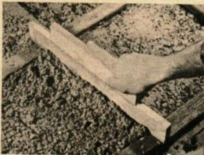
TECHNIQUE D'UNE NOUVELLE MODE. Une méthode pour faire des blocs de ciment coloré est donnée dans le texte. En voici une autre : aplanissez le ciment à 12 mm au-dessous du haut du coffrage,
