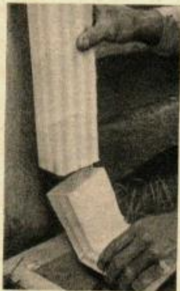
UNE NOUVELLE GOUTTIERE EN PLASTIQUE s'assemble avec de la colle (à gauche) ; elle fait 125 de large ; il suffit de coincer le tuyau de descente (à droite).
