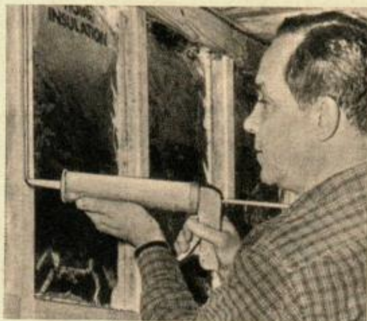
LA FORCE ADHESIVE CONSIDERABLE de cette nouvelle colle pour les panneaux, la fait préférer aux pointes dans bien des applications.
