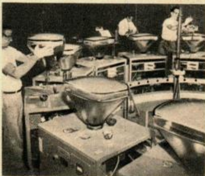
LES CHARIOTS MOBILES produisent un vide à l'intérieur des tubes de T.V., permettant à la vapeur d'aluminium de s'intégrer au verre. L'opération est complètement automatique.
