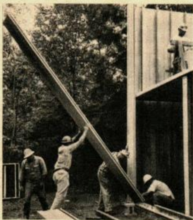
ON N'A PAS BESOIN DE PEINTURE pour cette maison construite en panneaux d'acier recouverts d'aluminium. Des échantillons de cet article ne montrent aucun signe d'usure après 20 ans d'exposition aux intempéries.
