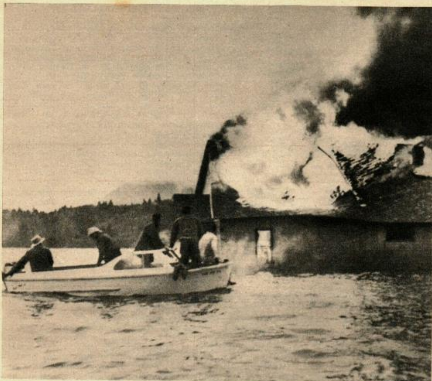
LES INONDATIONS DE L'OREGON ont été pour certains un désastre, tel le propriétaire de cette maison qui a pris feu. La panne d'électricité de New York (à gauche) a presque paralysé la vie de la grande cité.
