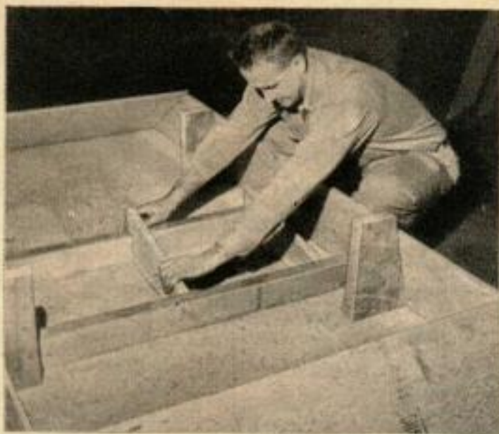
UN CALAGE TEMPORAIRE est réalisé avec des cornières. En clouant les panneaux d'extrémité en place, on obtient le même résultat.
