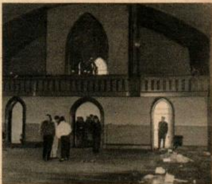
LE FEU EST JUGULE, la mousse a disparu. Comme on voit sur cette vue intérieure de l'église, la mousse facilite le nettoyage. Elle ne cause pas de dégâts au bâtiment comme les jets d'eau.
