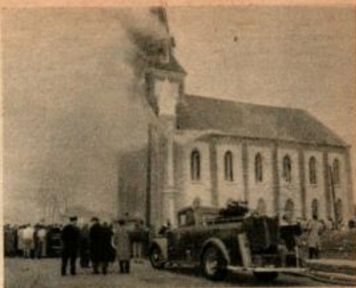
UNE EPREUVE TRES DURE. Les pompiers de Dayton, dans l'Ohio, ont mis le feu dans le sous-sol de cette église destinée à être démolie et ont laissé l'incendie se développer pendant 30 minutes.
