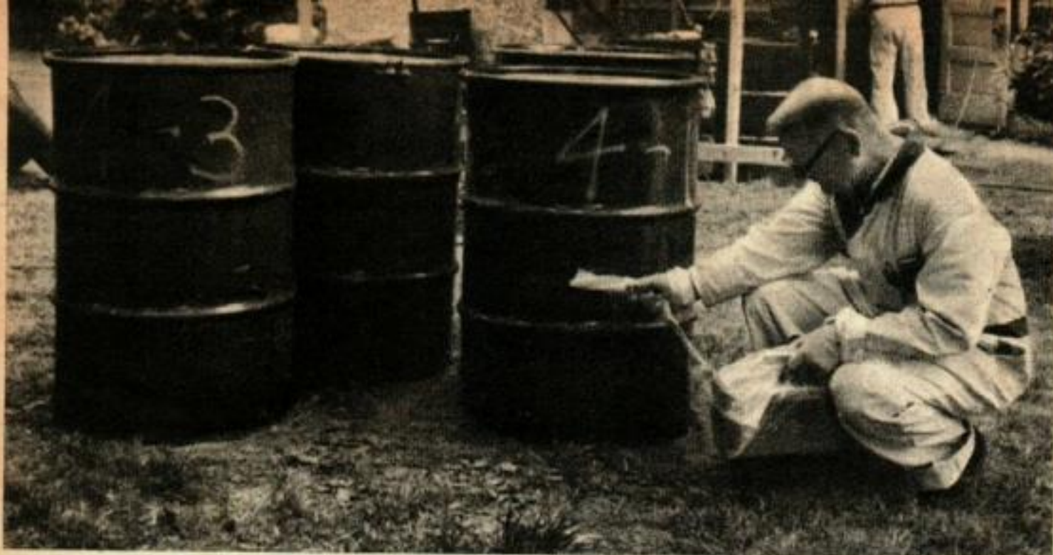
LES PARTIES CONTAMINEES de la maison de Lansdowne sont évacuées dans des fûts vers les décharges spéciales. Au total, 180 fûts de 200 l contenant en tout environ 30 mg de radium ont été évacués en 3 mois et demi de travaux.
