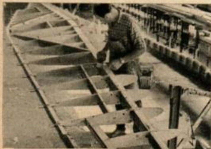
L'AILE DE 11 M D'ENVERGURE est la clef de voûte du « RF-3 ». Elle est très grande pour un avion de cette taille. Elle donne au planeur un taux de portance de 18.
