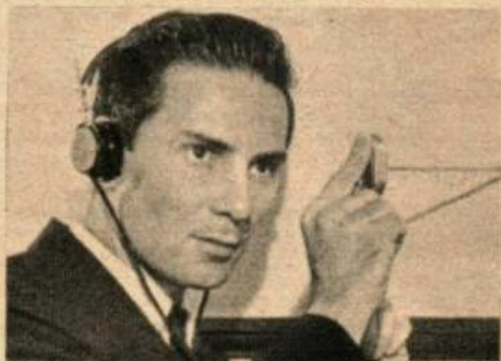
LE MICROPHONE A VIBRATION qu'on voit ici dans les mains de Bill Eaton, expert en recherches criminelles, permet d'entendre des paroles chuchotées de l'autre côté du mur. Cet appareil est assez petit pour être porté dans la poche.
