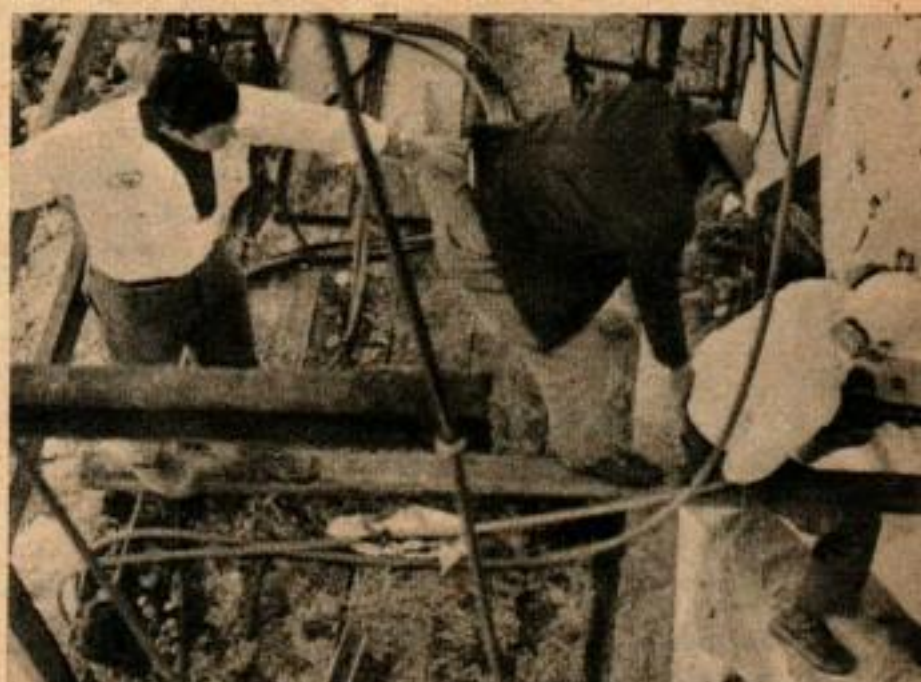
LE TRAVAIL D'EQUIPE joue un grand rôle pour la sécurité — l'homme qui est à califourchon sur la planche est maintenu par deux camarades qui font la chaîne. Les chiffres qu'on voit sur la paroi rocheuse indiquent la profondeur des trous pilotes à creuser.
