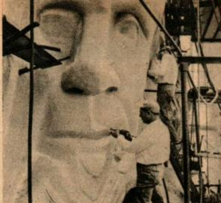
DE PETITS OUTILS pneumatiques sont utilisés pour égaliser les surfaces sur la bouche et l'oreille gauche du général Jackson. Les têtes des héros ont plus de 4,50 m de hauteur.
