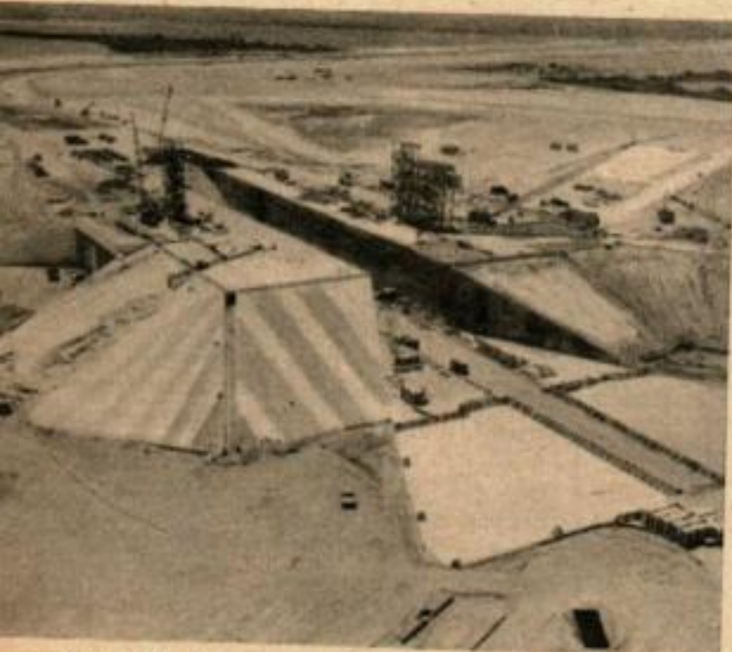
L'aire de lancement en construction a une petite pente de 5 degrés (au fond) ; c'est une phase critique pour la fusée en équilibre.
