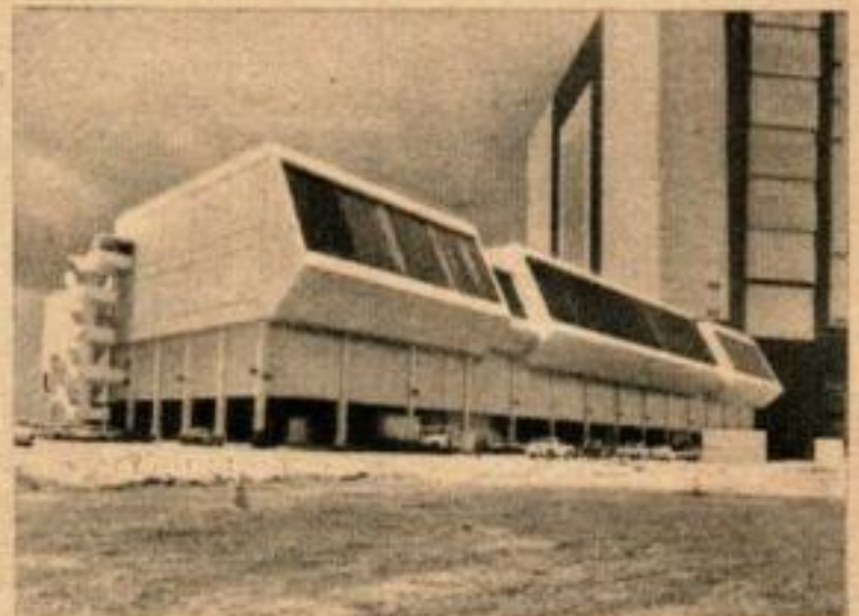
Les persiennes sombres commandées automatiquement arrêtent les rayons du soleil et donnent une visibilité parfaite sur l'aire de lancement.
