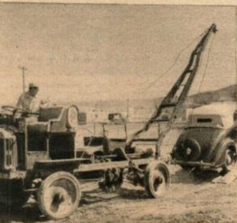
UN CAMION DE L'ARMÉE FRANÇAISE de 1918, un FWD, après avoir tiré longtemps un manège, sert de grue dans le dépôt ; on n'a même pas changé les bougies.
