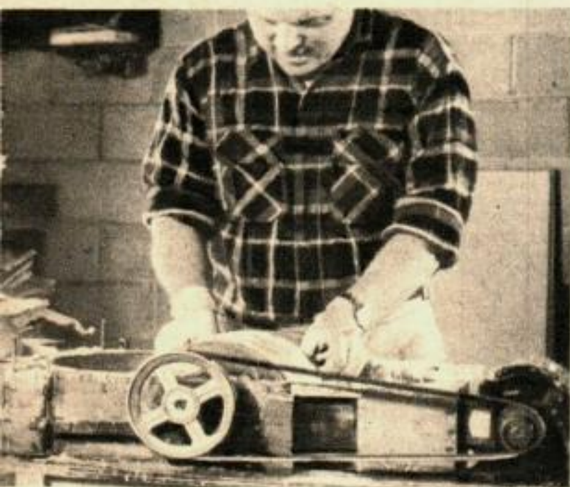
LE CAPOT est placé sur le tambour du raffineur où le mélange d'eau, de coton et de toile est transformé en pâte. Un moteur électrique reconstruit facilite le travail.
