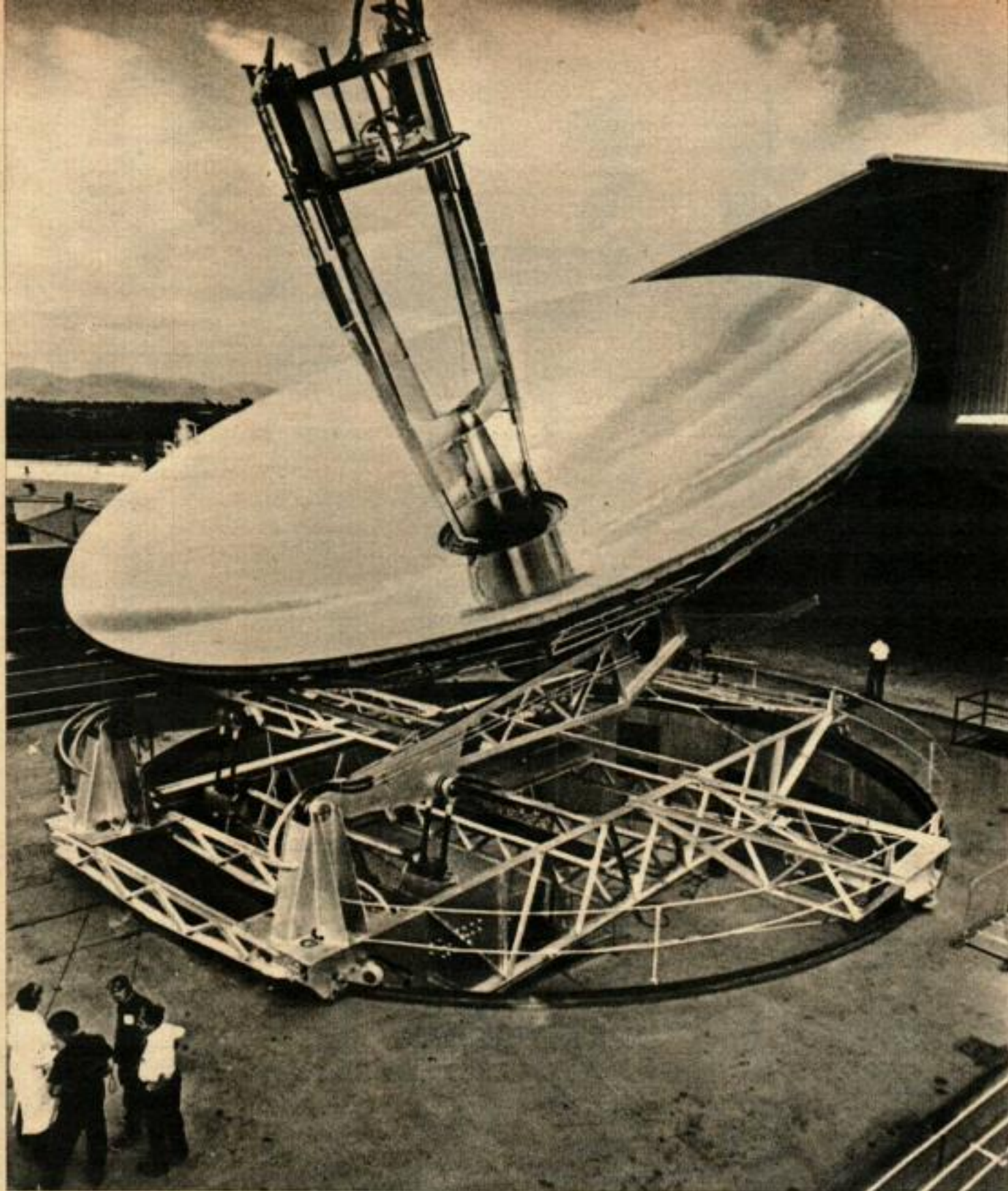
UNE DES INSTALLATIONS les plus modernes pour les recherches d'utilisations de l'énergie solaire, ce condensateur de 14 m de diamètre se trouve à Denver, dans le Colorado. Il peut produire des températures supérieures à 1 100° C et alimenter en électricité 30 maisons moyennes.
