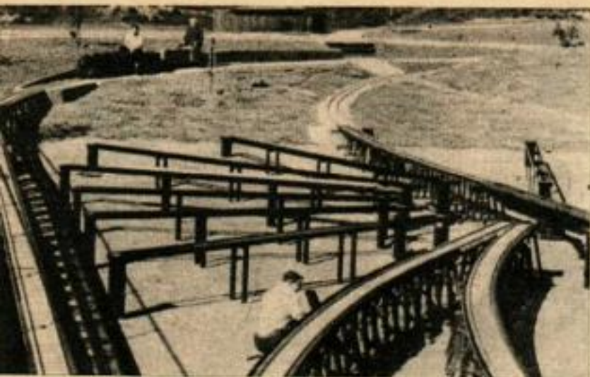
LES VOIES FERREES DU RESEAU JOHNSON comportent de voies de garage pour mettre les locomotives sous pression avant de les lancer sur les voies principales. Tout le réseau sera achevé en 1967.
