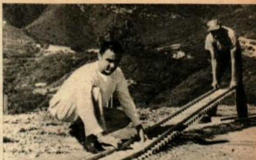
LES MEMBRES DU CLUB aident à installer des voies à l'échelle de 1/8 sur la colline aménagée par Johnson. Les rails en aluminium sont fixés sur les traverses en bois dur par des chevilles miniatures en acier.
