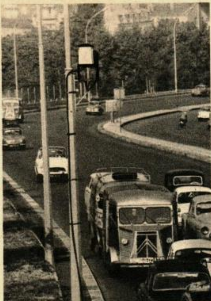
A la porte de Gentilly, une caméra permet le contrôle local du trafic.
