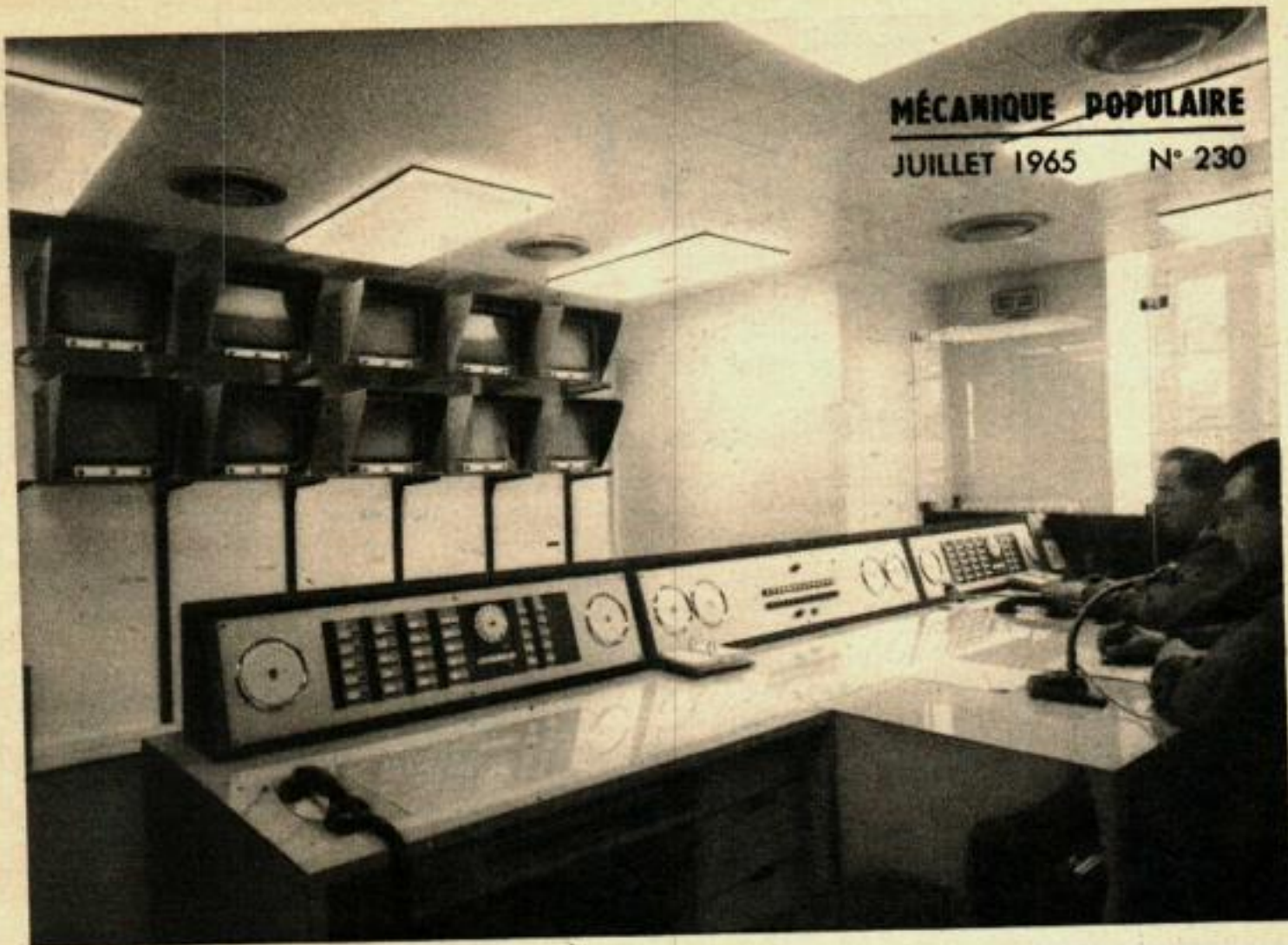
A Paris, les responsables de la circulation dans la salle d'information et de commandement ont devant eux 10 écrans de télévision. Depuis le mois de juin 1965, il y en a trois qui fonctionnent, trois caméras ayant été installées à divers points aux environs de la place de la Concorde.
